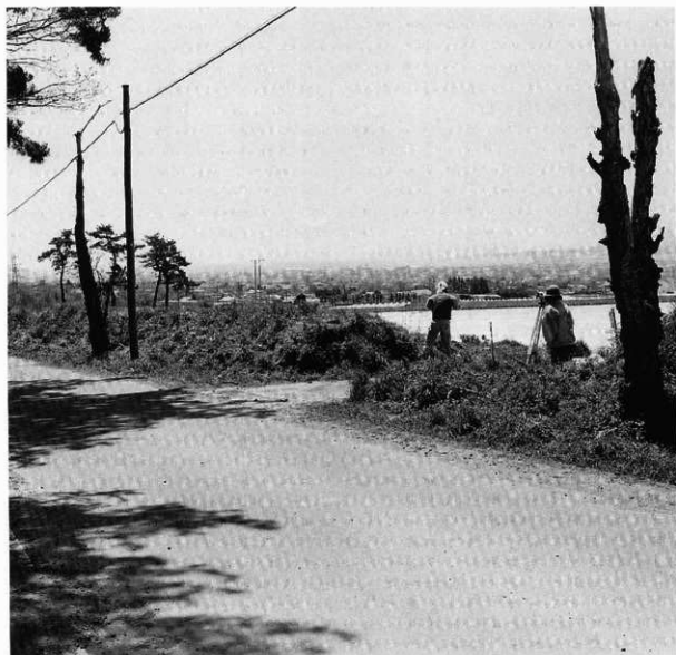
1 地形測量風景 (北東から)
