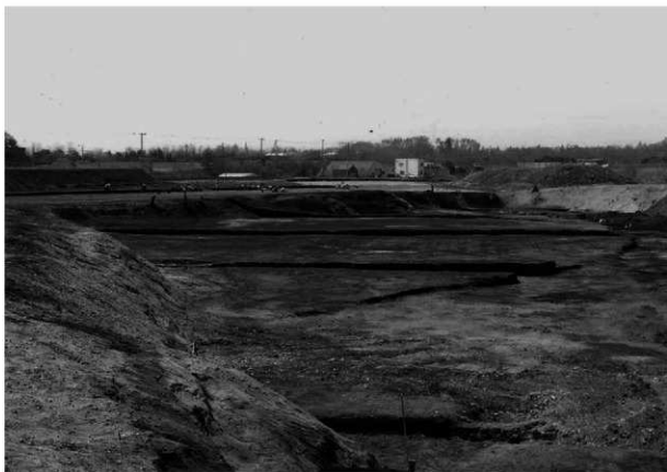
トレンチ設定状況 NE→SW
