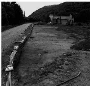
5 調査終了(北東から)
