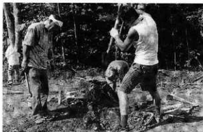
2. 切り株除去作業風景 (N→)
