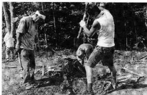
2. 切り株除去作業風景 (N→)
