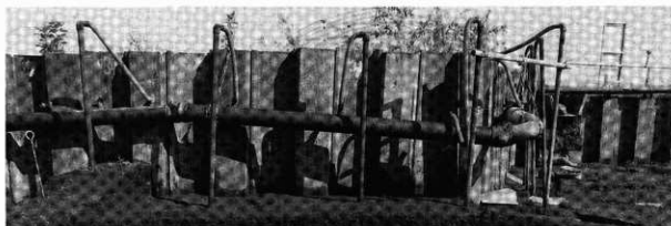
ウエルポイント吸水管設置状況
