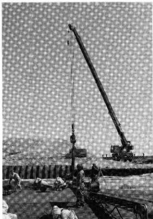
鋼矢板設置状況
