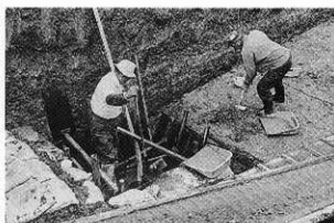
カマ場設置作業風景 SW→NE
