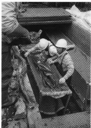
屋外水槽保管作業
