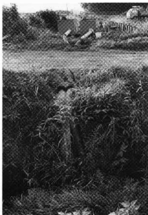
排水状況 E→W
