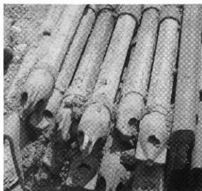
吸水管先端部
