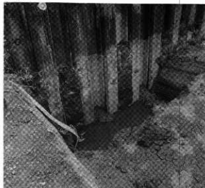
カマ場設置状況 NW→SE
