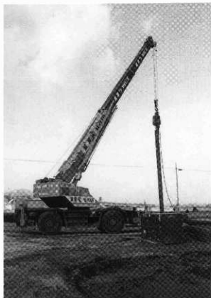
鋼矢板設置状況 W→E
