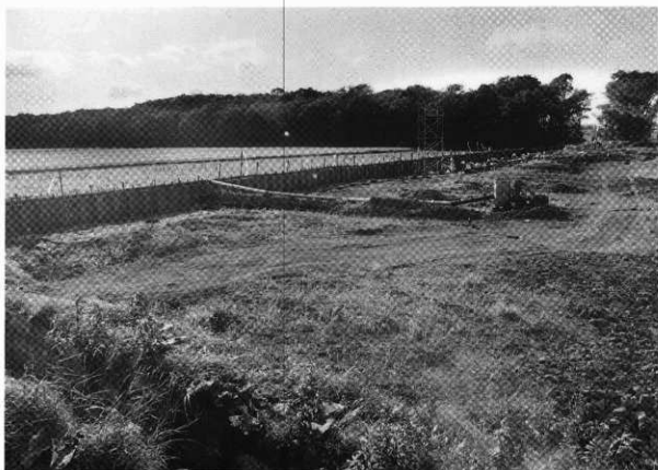
ウェルポイント設置状況 NE→SW
