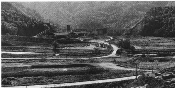
図版 I-1 滝里ダム本体工事遺景
