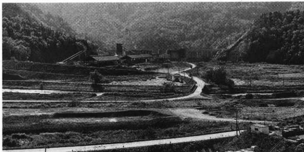
図版 I-1 滝里ダム本体工事遺景
