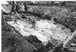
3 越冬のためのシート貼り作業 (W→E)
