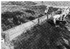
2 斜面部整地と土留板設置状況 (SW→NE)
