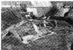
2 崩落防止作業終了 (W→E)
