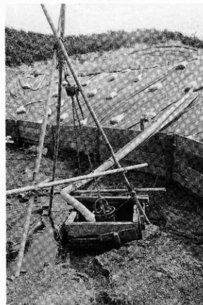
3 4インチポンプの釜場設置状況 (W→E)
