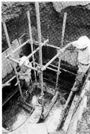
1 6インチポンプの釜場設置状況 (NW→SE)
