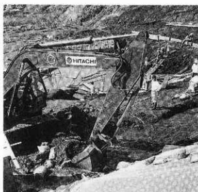
2 バックホウによる排水清掃 (E→W)
