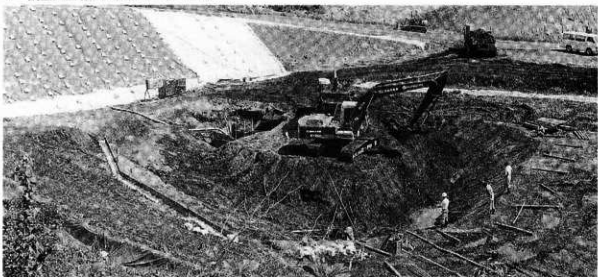
2 調査区盛土除去状況 (W→E)
