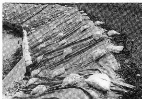
3 法面保護シート貼り状況 (W→E)
