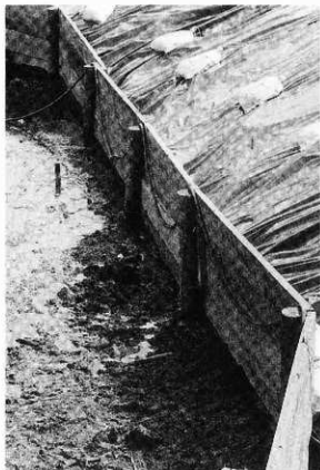
1 法面下部土留板設置状況 (W→E)
