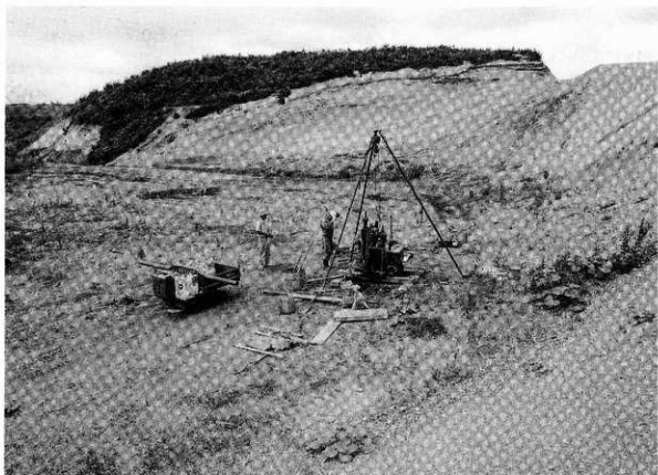
1 ボーリング調査風景 (SE→NW)
