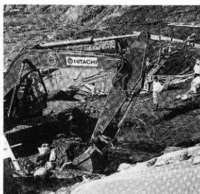
2 バックホウによる排水溝清掃 (E→W)
