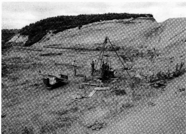
1 ボーリング調査風景 (SE→NW)
