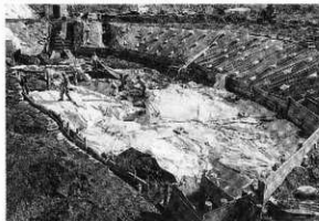
3 越冬のためのシート貼り作業 (W→E)
