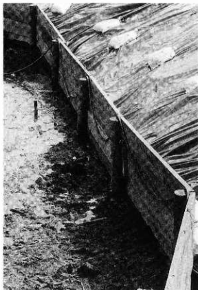
1 法面下部土留板設置状況 (W→E)
