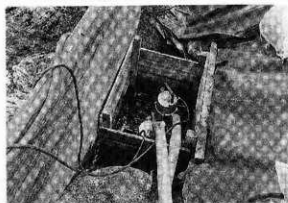
4 2インチポンプの釜場設置状況 (W→E)
