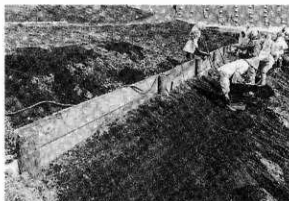
2 斜面部整地と土留板設置状況 (SW→NE)
