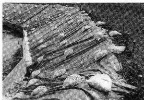
3 法面保護シート貼り状況 (W→E)
