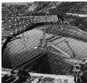
3 冠水状況 (E→W)
