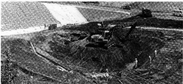
2 調査区盛土除去状況 (W-E)
