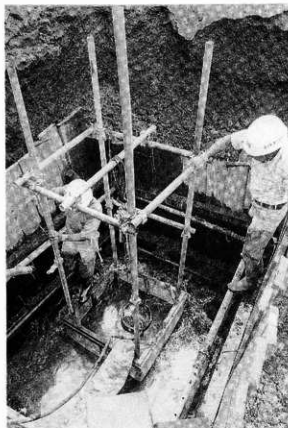
1 6インチポンプの釜場設置状況 (NW→SE)
