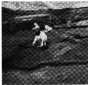
6 表土 道跡-2 調査状況 N→
