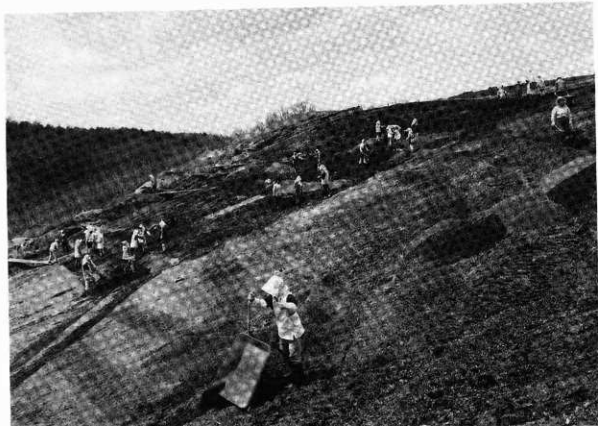
1 斜面作業風景 SE→
