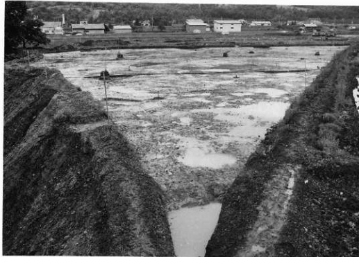
中地区の作業終了状況
