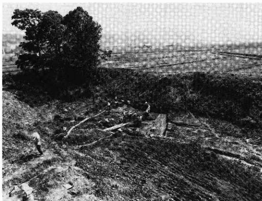
沢地区の作業状況
