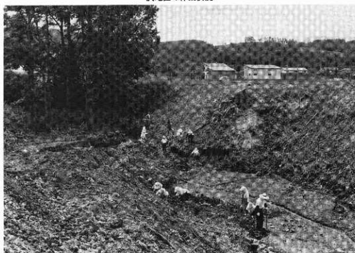
沢地区の作業状況
