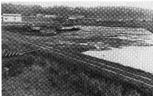
南地区の作業状況
