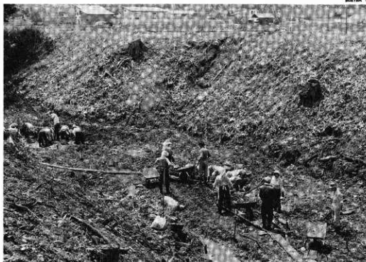
沢地区の作業状況
