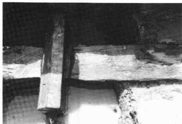
2、継手r東側から
