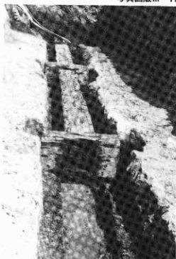
管をはずしたところ
