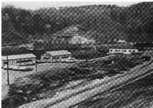
作業風景 (黒色土除去 SE → NW)
