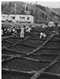
作業風景 (北地区 暗褐色土Ⅱ層上層除去 S→N)
