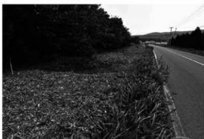
草刈り後の調査区中央部の凹み
