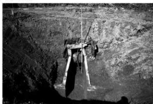
灌溉用水路跡「樋門」
