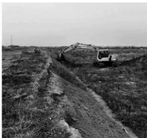
遺跡保護工事状況
