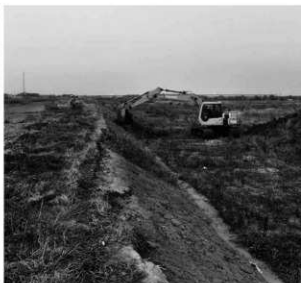
遺跡保護工事状況
