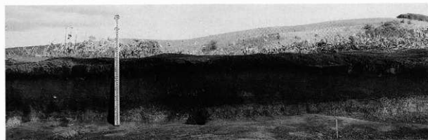
盛土の土層断面 (JM-1)
