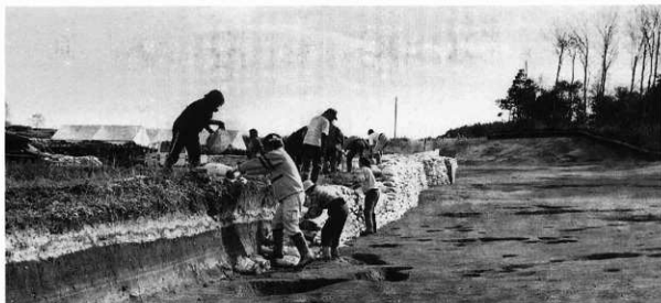
作業風景 (来年度調査区の養生)
