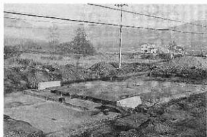
A地区完掘風景（南から）
