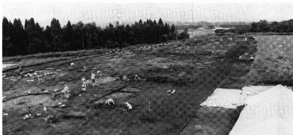
調査状況（南西から）
