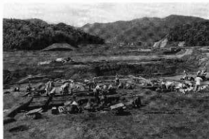
調査状況（北から-正面奥にダム）
