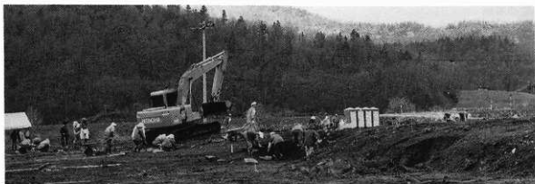
滝里9 調査状況
