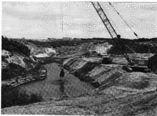
クラムシェルによる遺物採取状況 (B地区)
