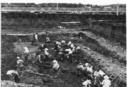
砂礫層調査状況
