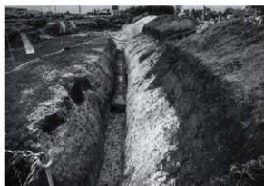
1号堀跡 完掘 (S→)
