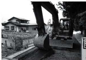
調査前 (西から)
