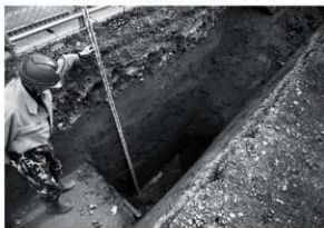
1区南端部深掘り
