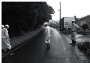
調査前現況 (東から)
