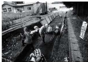
検出作業 (西から)
