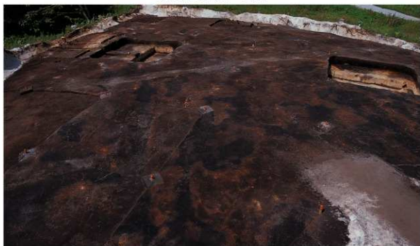
太い畝間と交叉する畝 (Q~V 43~48区)
