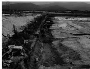
7-4 1地区 旧河川完掘状況(北から)
