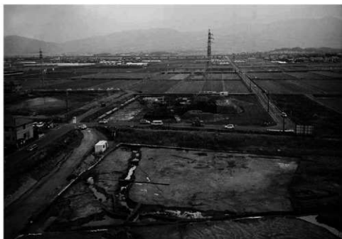
1-1 A地区 全景 (北から)
