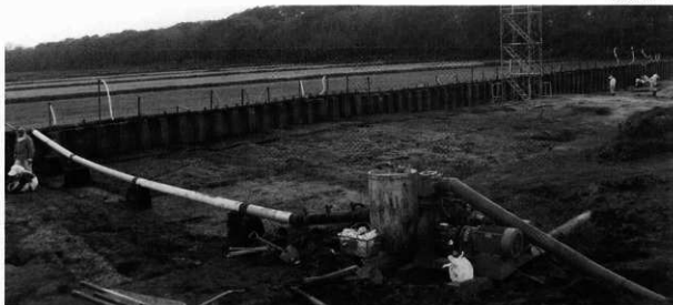
ウェル・ポイント設置状況
