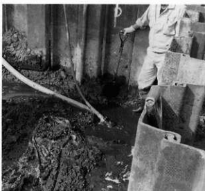
カマ場設置状況
