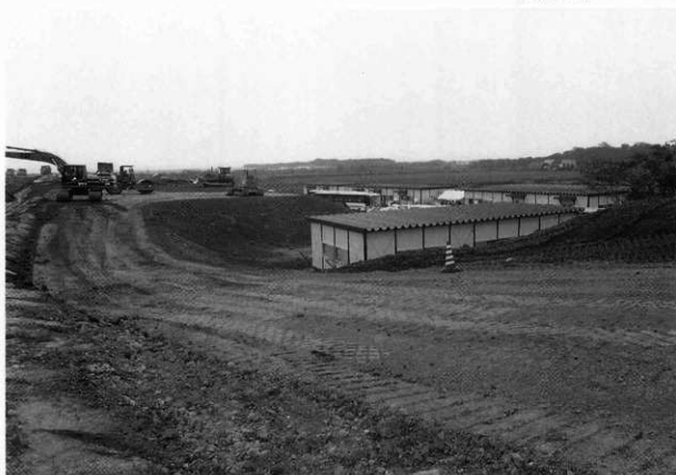
工事進行状況 NW→SE
