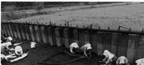
鋼矢板設置状況
