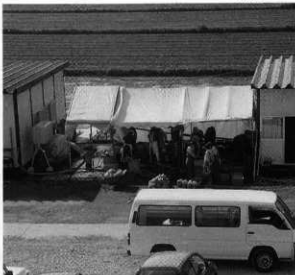
土壌水洗用仮設テント
