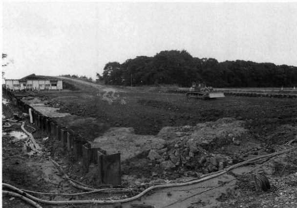
埋め戻し作業 SE→NW
