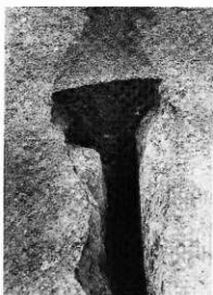
5 TP-132土層断面 (北から)
