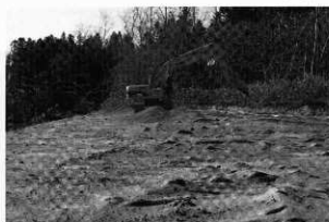
2 火山灰（Ko-g）除去作業（北から）
