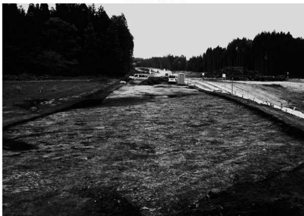
遺構確認区完掘（南西から）
