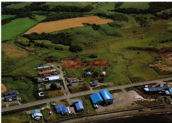
3 空中写真(北より)
