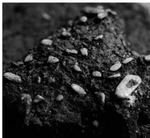
3 S-3 確認状況 (西から)
