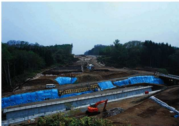
1 遺跡遠景（北西から）
