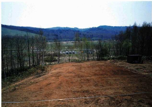
東地区 表土除去後
