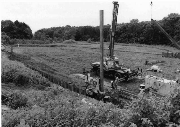
鋼矢板設置工事
