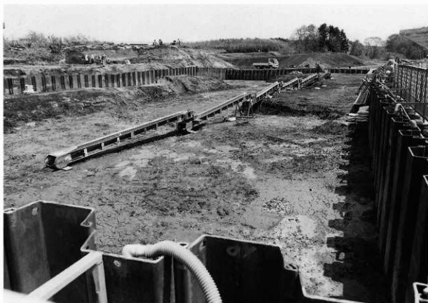
準備工事完了
