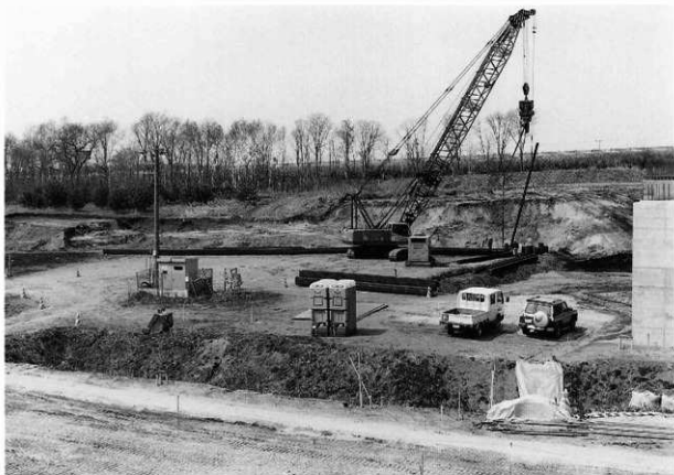
鋼矢板設置工事
