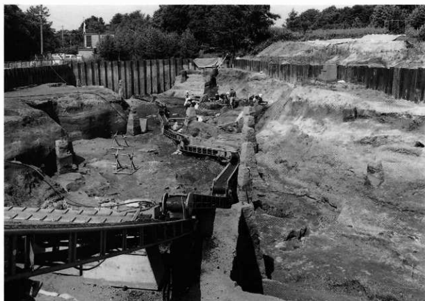
平成18年度調査区 旧河道完掘状況
