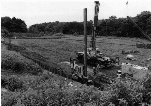
鋼矢板設置工事
