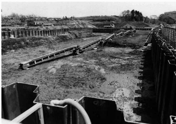
準備工事完了
