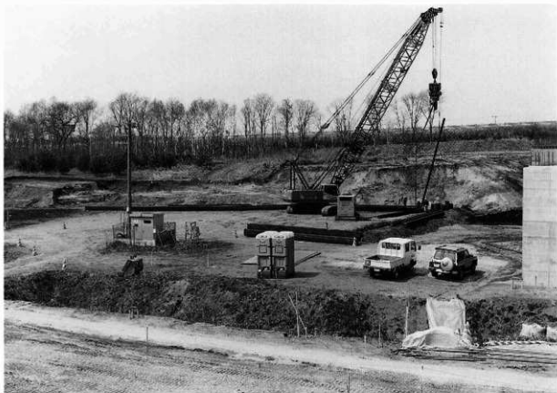
鋼矢板設置工事
