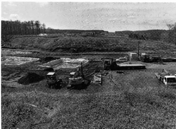
平成17年度調査区Ta-a火山灰除去後（北東から）
