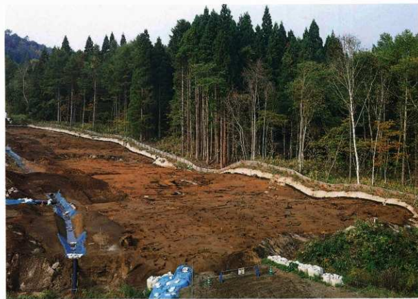
A地区 海側完掘
