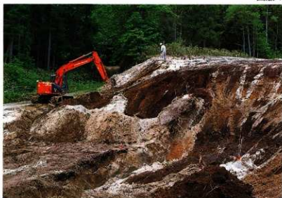
重機による火山灰除去 (F32区付近)
