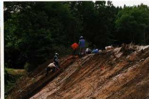
斜面 調査状況
