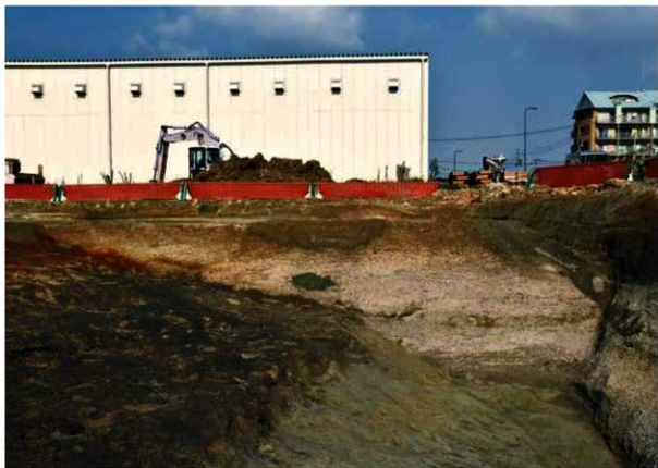
(2) SD01中央土層 (南から)
