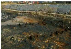
(2) 杭列B・C (北西から)
