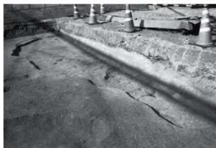
(4) 12-SX101 完掘 (南東から)
