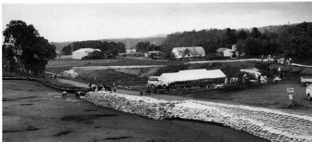
1 作業風景(次年度調査区保護、南から)
