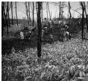
4 作業風景(作業用道路整備、西から)
