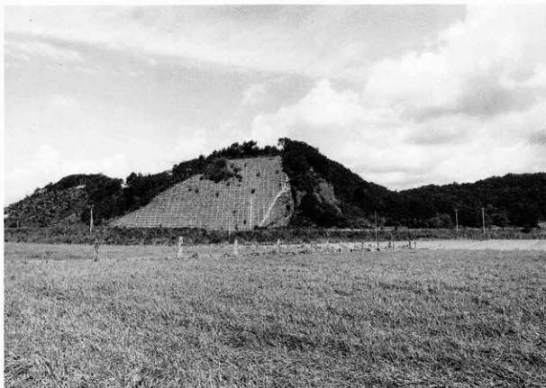
1 「オマンルバル」 遠景(南西から)
