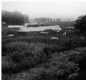
4 常時のイモッペ川と土嚢(南東から)
