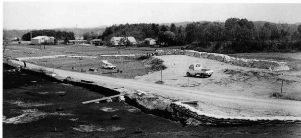
1 土嚢集積状況(南から)
