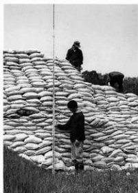
2 土嚢集積状況(東から)
