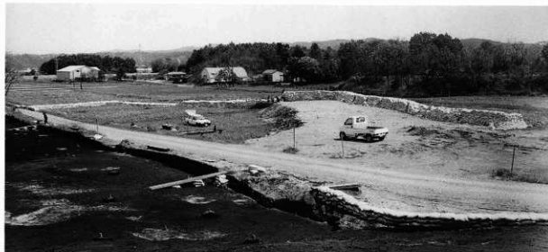
1 土嚢集積状況(南から)
