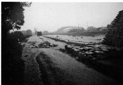
3 イモッペ川の氾濫による町道米原2線の冠水状況(南から)
