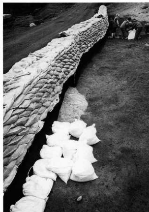
4 TP-18埋め戻し状況(北西から)
