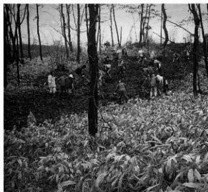
4 作業風景(作業用道路整備、西から)
