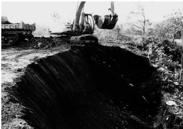
1 攪乱貝層回収作業状況(南から)
