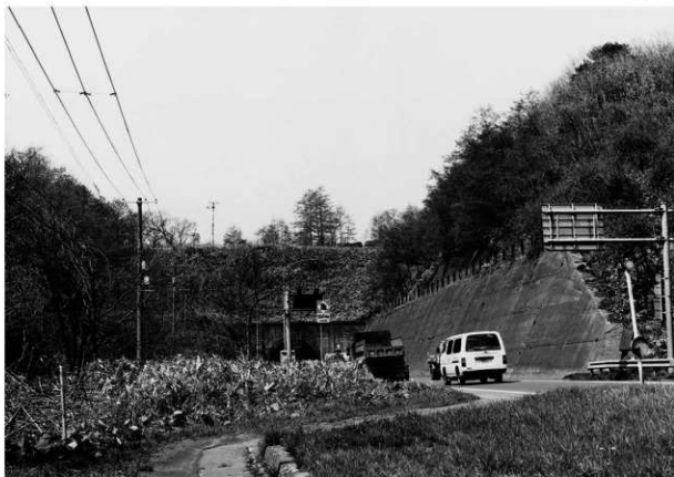
1 遺跡遠景 虎杖浜隧道(北から)
